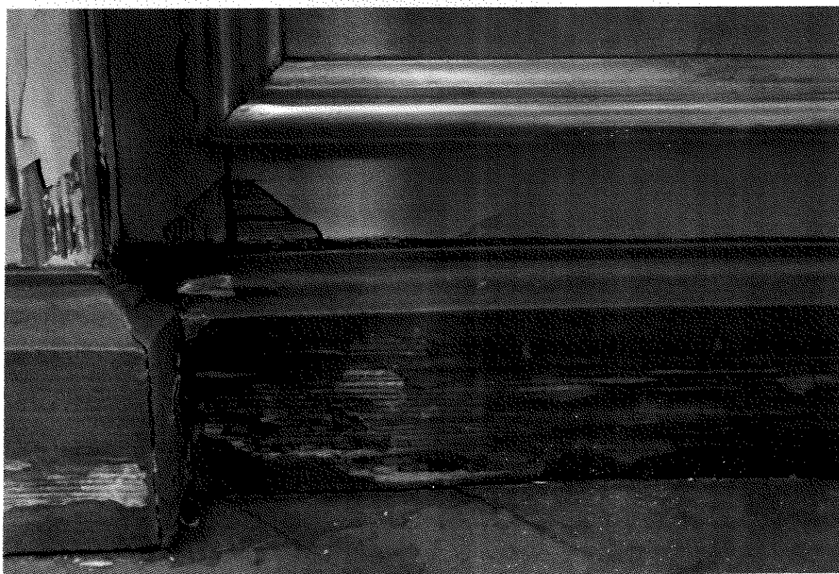
Fot. nr 4 – Chełm, Cerkiew prawosławna p.w. Jana Teologa, Ikonostas. Zniszczenia partii cokołowej. Wyk. M. Podgórska - Makal. Czerwiec 2016.
